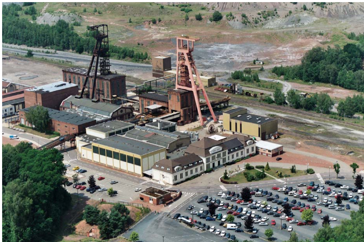
Vue générale du site de la Houve à l'époque de son activité ( Photo charbonnage de France )
