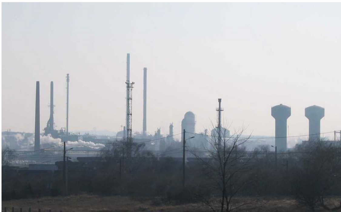
Plate forme chimique de Carling (photo DIREN Lorraine)
