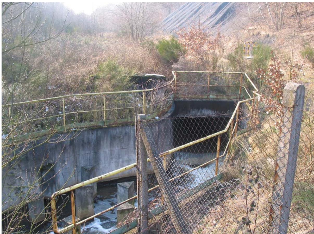
Le Merle à la sortie de son tronçon sous couverture (photo DIREN Lorraine mars 2004)
