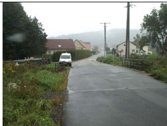
Vue de l'accès au niveau du pont
