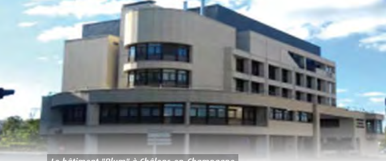
Le bâtiment "Blum" à Châlons-en-Champagne
