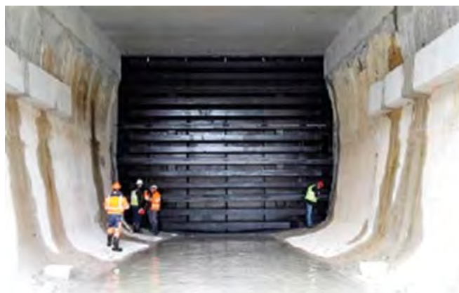
Canal d'aménée Seine - Aube (10) - Essai de la fermeture amovible à l'extrémité amont du tunnel du canal d'aménée - Novembre 2018 - (photo EPTB SGL)
