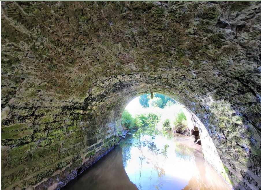
Vue d'ensemble de la voûte en maçonnerie
