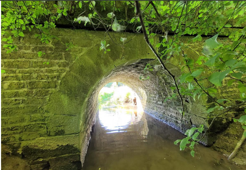
Parement aval de l'ouvrage d'art
