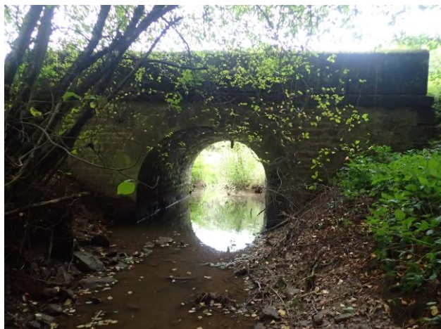
Figure 3 : Pont rue des Grands Jardins, vue aval vers amont
