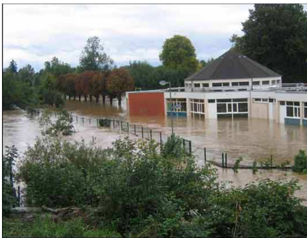
Rambervillers : école Void Régnier © Mme COULAUD octobre 2006
