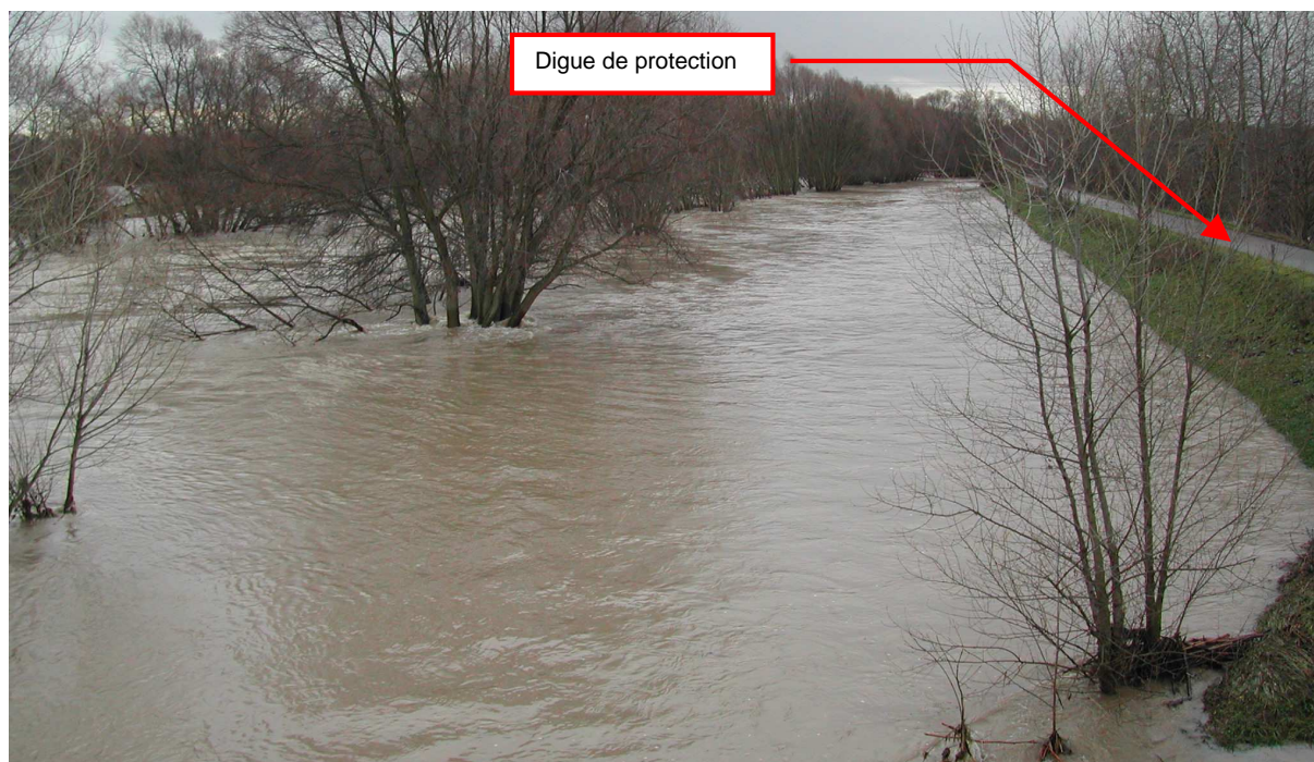
Photographie 1 : digues de protection en rive gauche de l'Ill à hauteur Sausheim-Kingersheim lors de la crue de janvier 2004 (vue vers l'amont depuis le pont de la RD55) 15
