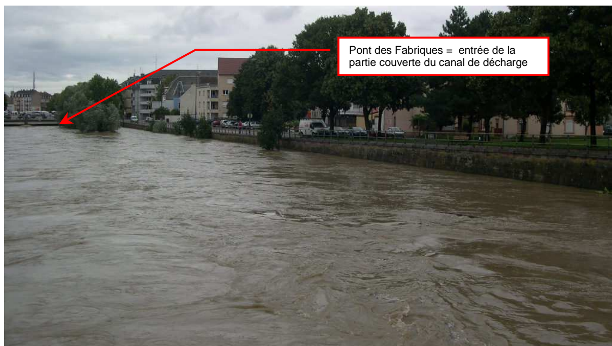
Photographie 2 : vue du canal de décharge de l'Ill à l'amont du pont des Fabriques lors de la crue d'août 2007 21
