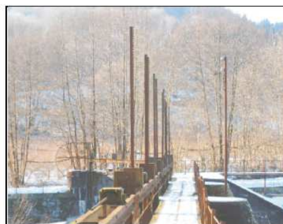
Photographie 10 : Vue de la passerelle du barrage et système de manoeuvre des vannes
