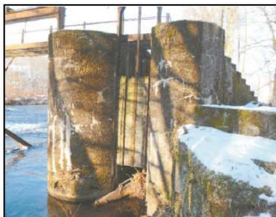
Photographie 7 : Vue de la vanne de décharge en rive droite
