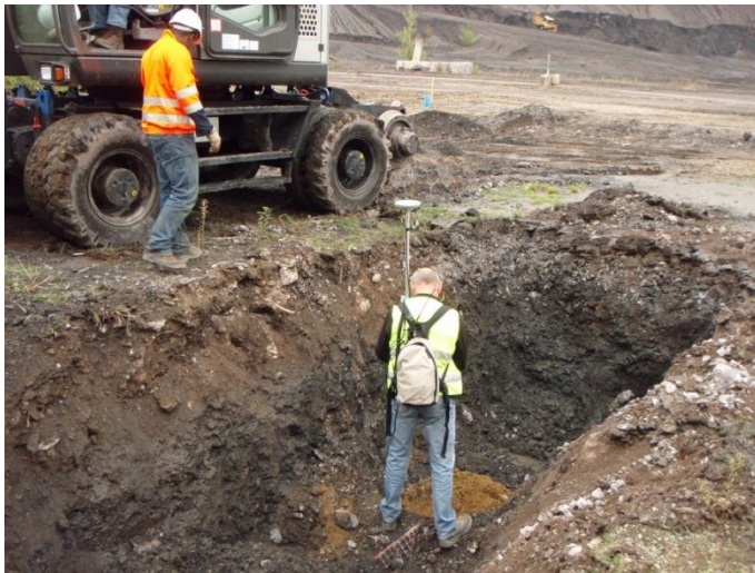
Fouilles pour localisation des réseaux de conduites AEP
