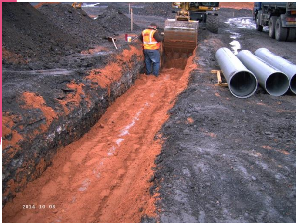
Mise en place du réseau hydraulique gravitaire entre les bassins
