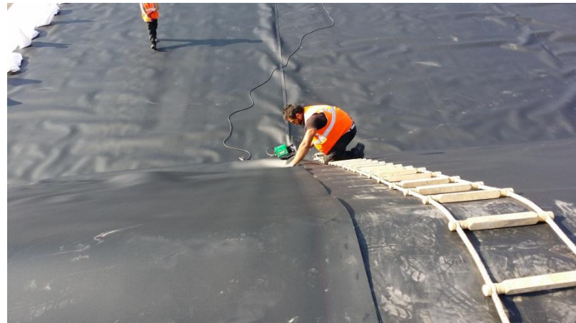
Etanchéification des bassins
