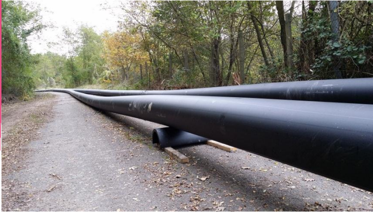
Réalisation des 1600 m de conduite Ø400 PN16 pour le refoulement entre la station de pompage et la station de traitement de l'eau
