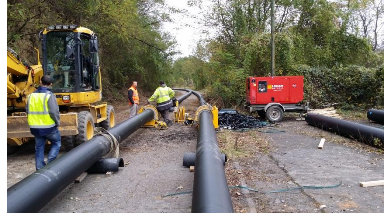
Réalisation des 1600 m de conduite Ø400 PN16 pour le refoulement entre la station de pompage et la station de traitement de l'eau
