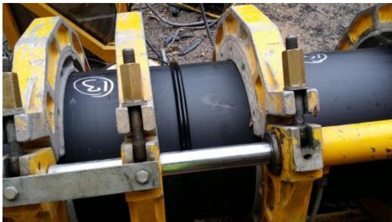
Assemblage de la conduite par thermo-soudage
