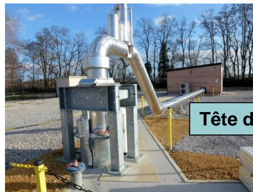
Fosse en tête de puits avec rehausse du tubing et avant comblement
