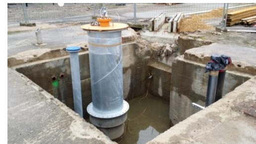
Fosse en tête de puits avec rehausse du tubing et avant comblement
