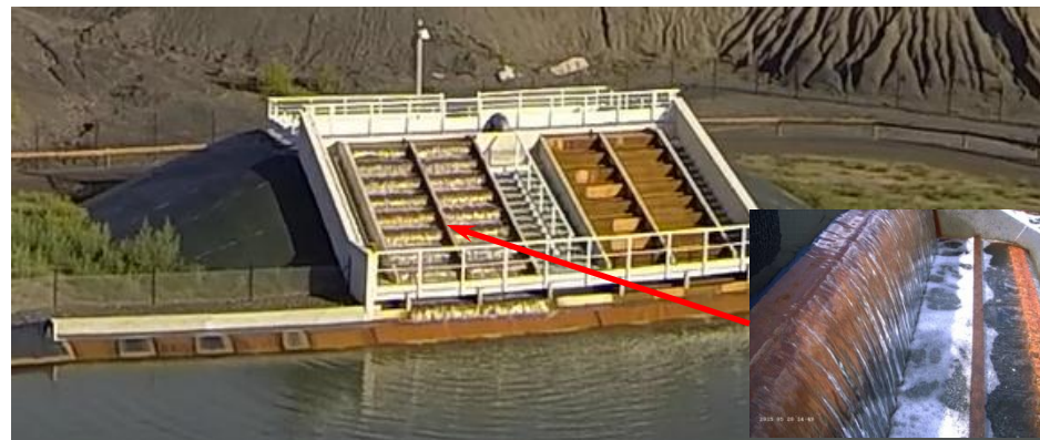
Cascade d'oxygénation avec marches creuses
