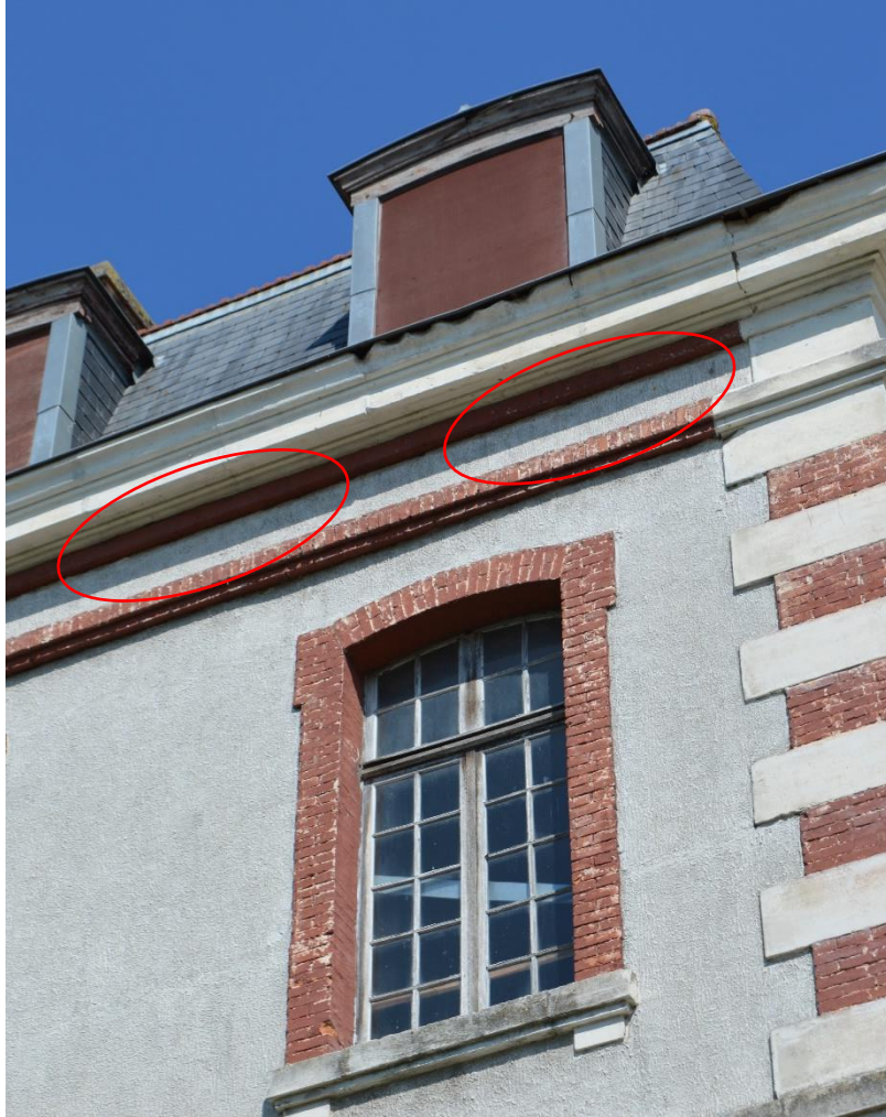
Figure 9 : Localisation possible des nichoirs à martinet sur les façades
