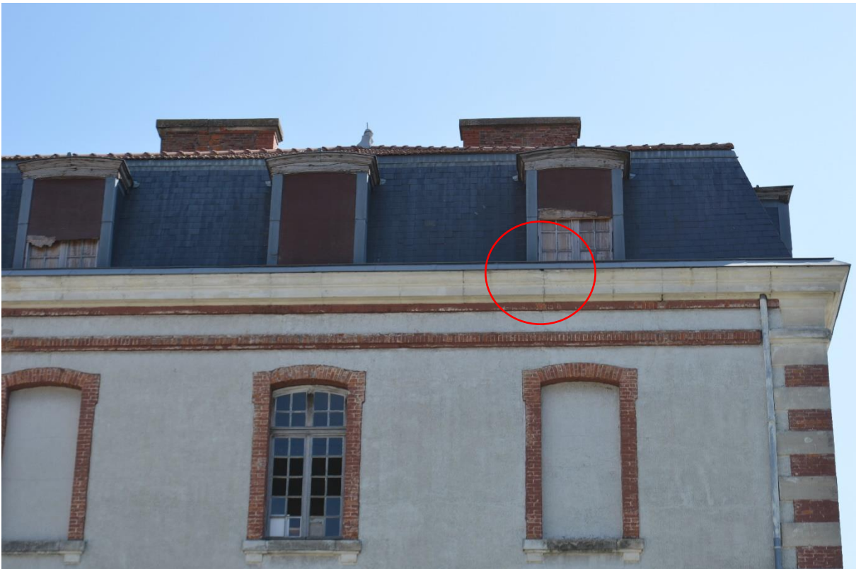
Figure 2 : cavité occupée par un couple de Martinet noir sur la façade sud-ouest
