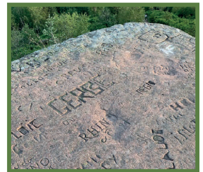
Exemples de dégradations sur le Donon
