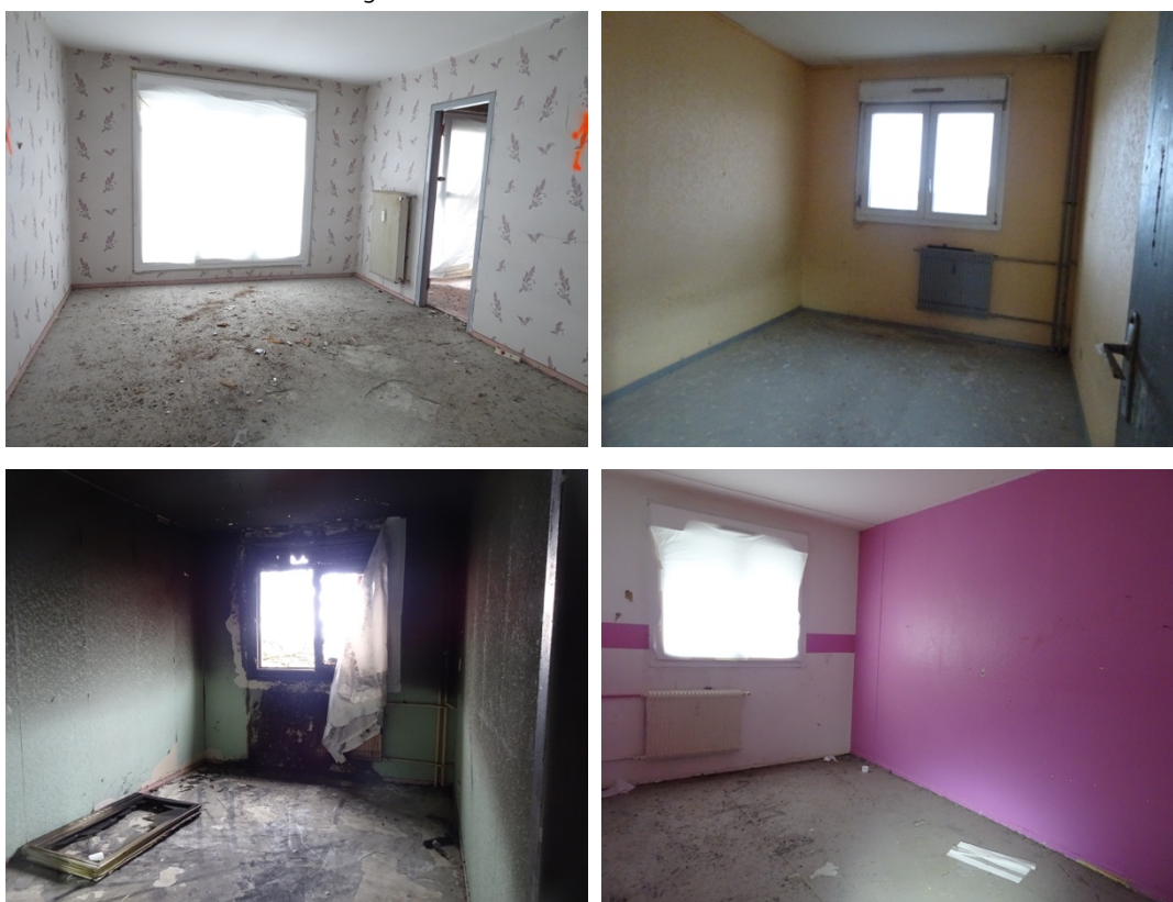
Figure 3 : Pièces intérieures de l'immeuble
