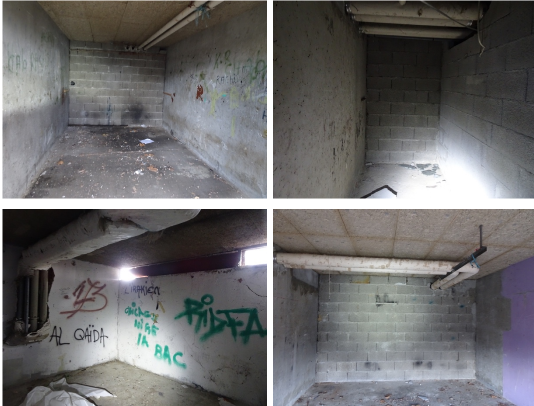
Figure 5 : Caves et garages de l'immeuble
