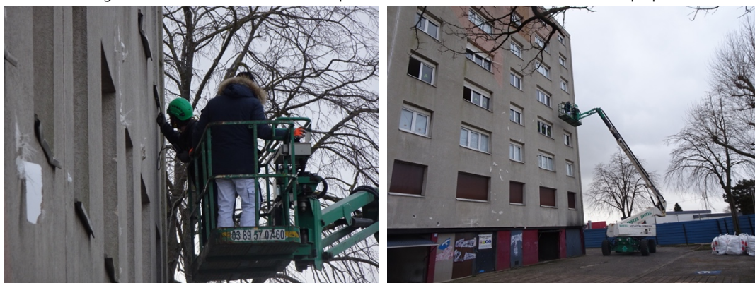
Figure 6 : Accès en nacelle et expertise à l'aide d'une caméra endoscopique
