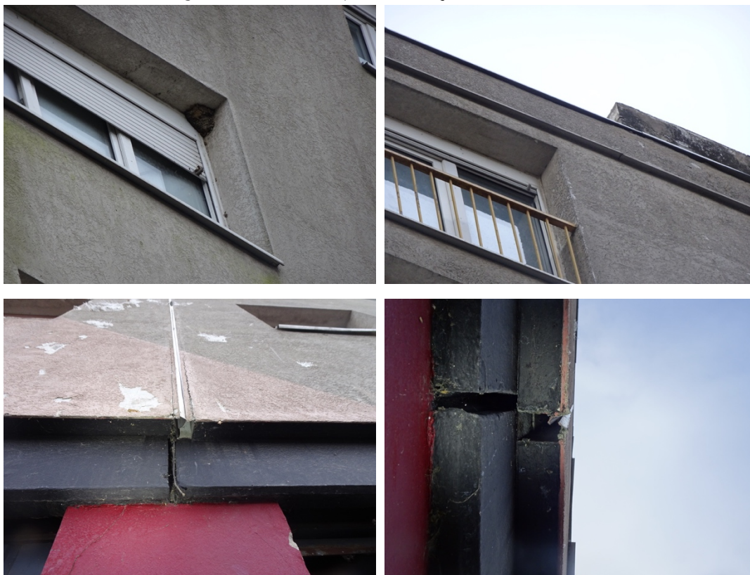
Figure 6 : Éléments inspectés en façade de l'immeuble
