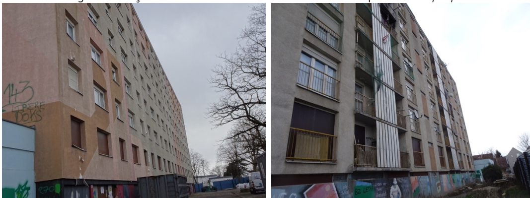
Figure 2 : Façades nord et sud du bâtiment soumis à expertise le 21/02/22
