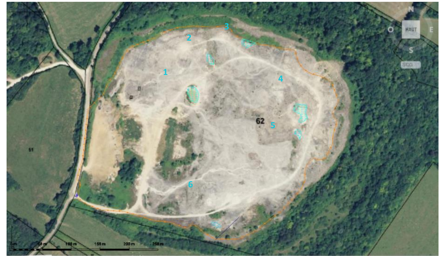
Figure 12 : localisation et position des mares temporaires
