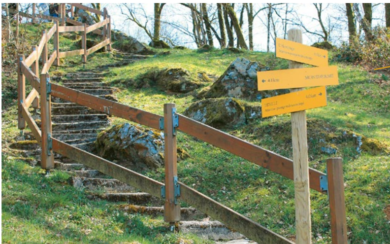
Accès au sommet de la roche
