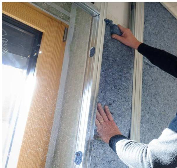
Pose d'un isolant biosourcé à base de textiles recyclés.
