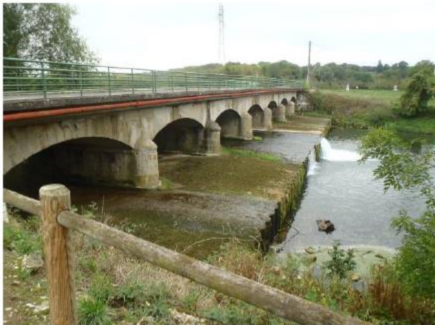
Ouvrage de Neuville-sur-Ornain
