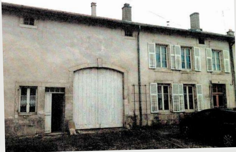
Cette fiche s'appuie sur l'exemple réel d'une maison située en Meuse.
