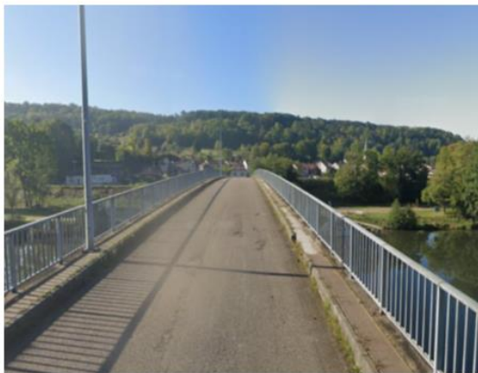
Vues générales de l'ouvrage
