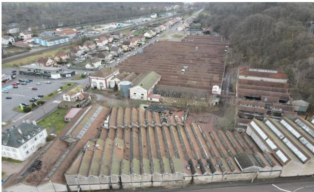
Figure n°8. Vue aérienne par le nord. On distingue les toitures typiques en sheds de l'ancienne teinturerie (1 er plan) et filature (2 nd plan) de Nomexy.
