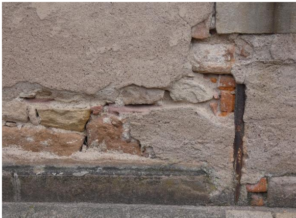
Interstices proches du sol façade nord.
