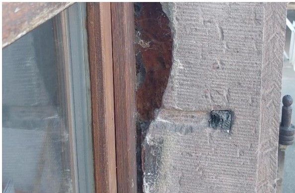
Exemple d'interstice non favorable aux chauves-souris sur un encart de fenêtre façade nord.
