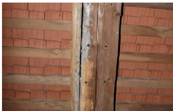
Exemple de fissures dans le bois de la charpente
