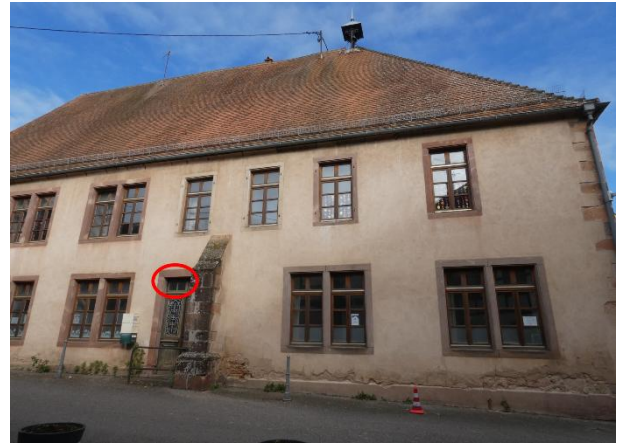
Localisation des interstices favorables sur les encarts de fenêtres sur la façade sud.
