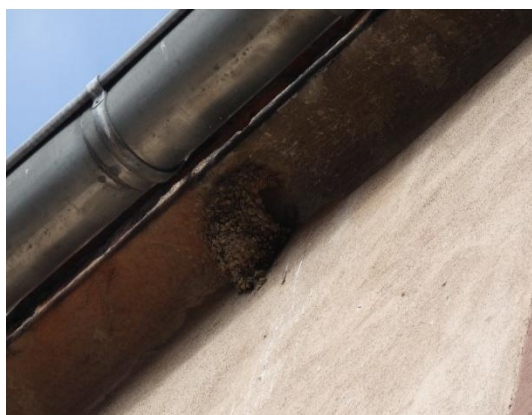
Un nid d'Hirondelle de fenêtre sur la façade côté sud.
