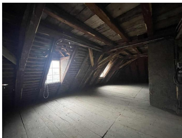
Niveau C1 – Charpente surplombée par le plancher du niveau C2 et fenêtres côté rue
