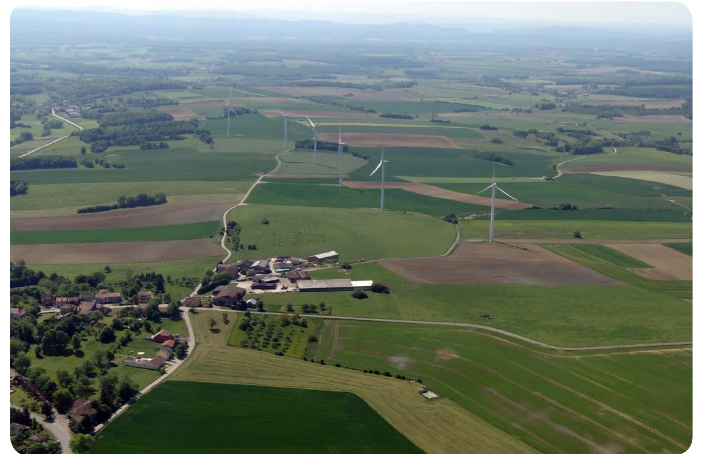
commune d'Alsace Bossue (67) : cinq éoliennes d'une capacité de dix mégawatts de production
