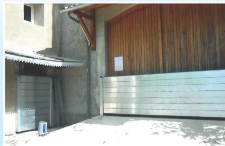
Photographie 1 : mise en place de batardeaux (CA26).
