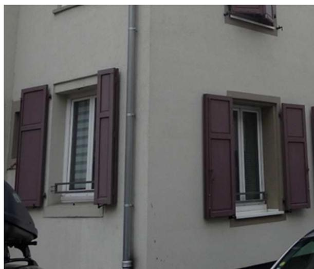
Figure 8 : jonction entre une façade non isolée à gauche et une façade isolée à droite. Depuis la rue il y a une différence visuelle entre les encadrements de baies en relief sur les façades préservées et les encadrements peints sur l'ITE des façades en retour (photo Cerema)
