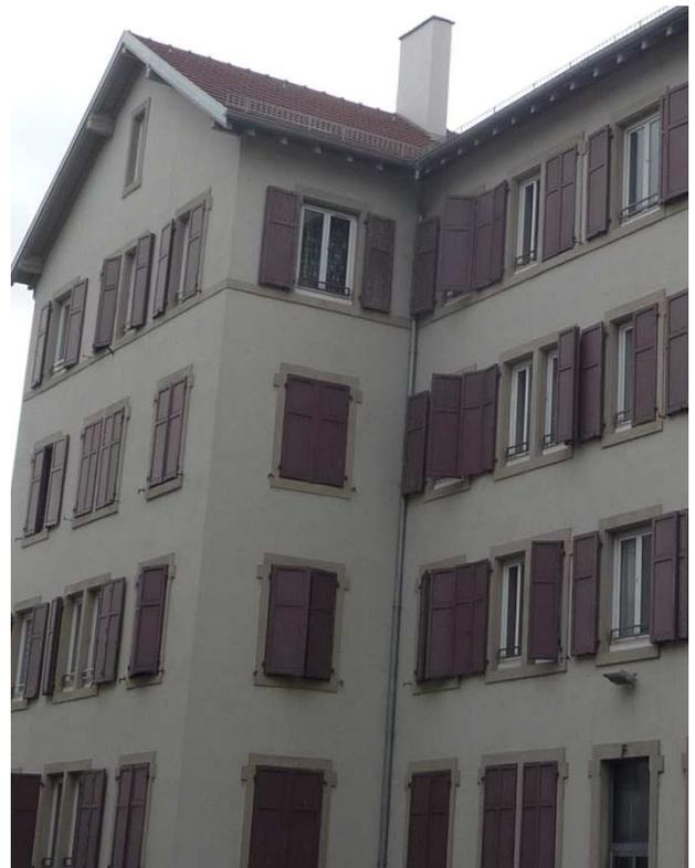
Figure 11 : après travaux, façade non isolée avec encadrements de baies d'origine (photo Cerema)
