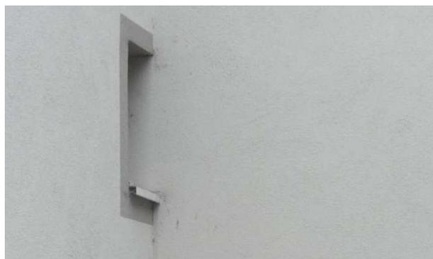
Figure 10 : difficulté à restituer certains encadrements. Dans cet angle rentrant entre deux façades isolées, le piédroit de la baie disparaît complètement sous l'isolant. (Photo Cerema).
