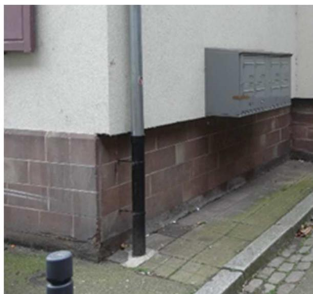
Figure 9 : jonction entre une façade non isolée à gauche et une façade isolée à droite. L'isolation par l'extérieur créé un débord au-dessus du soubassement (Photo Cerema).
