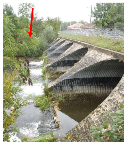
Figure 28. Buse RD du pont Mussey, obstruée par la charge alluviale (Cariçaie)
