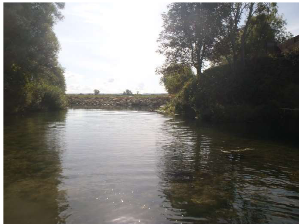
Figure 48. Vue de l'accès Sud vu depuis le cours d'eau (Cariaçie)
