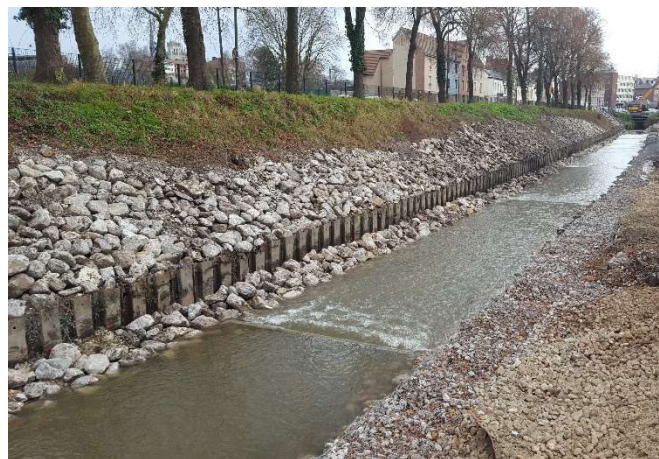
Figure 26 et Figure 27. Exemple de prébarrages (Cariçaie)
