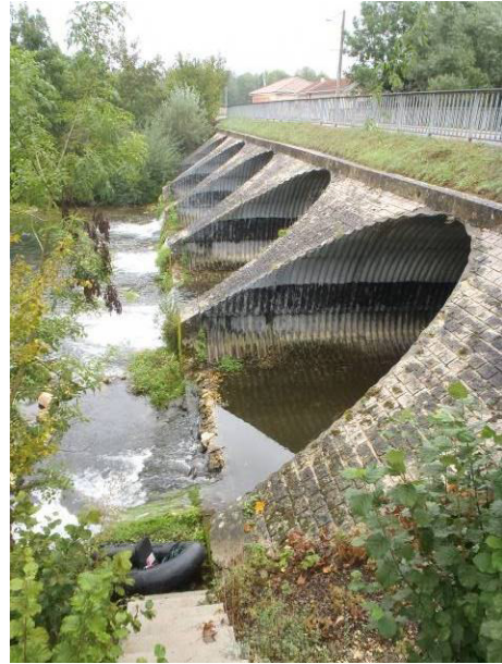
Figure 6. Pont de Mussey vu depuis l'aval (Cariçaie)
