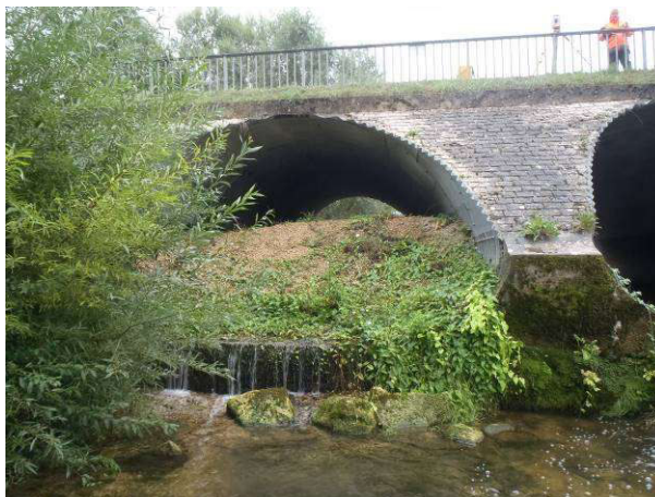
Figure 28. Buse RD du pont Mussey, obstruée par la charge alluviale (Cariçaie)
