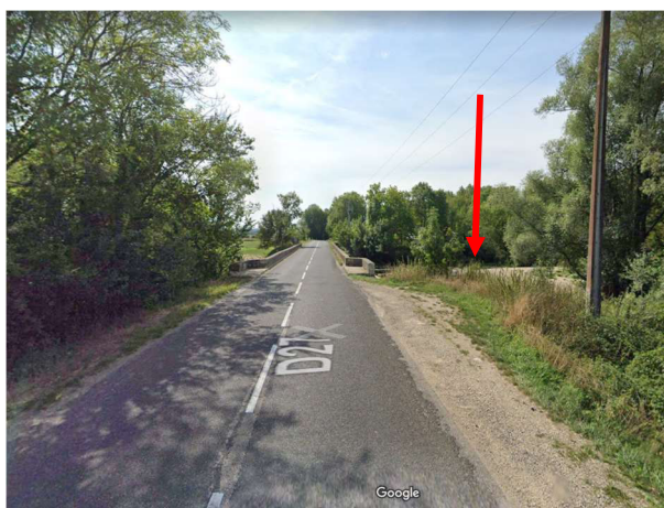
Figure 45. Localisation de l'accès Nord vu depuis la route (Google)
