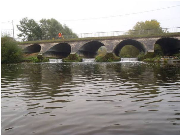
Figure 7. Pont de Mussey vu depuis l'aval (Cariçaie)
