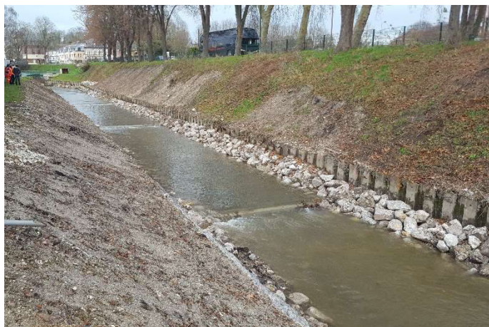
Figure 26 et Figure 27. Exemple de prébarrages (Cariçaie)
