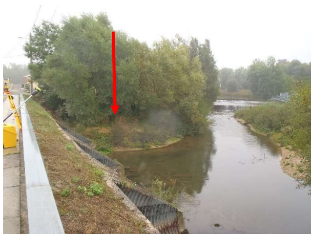
Figure 28. Buse RD du pont Mussey, obstruée par la charge alluviale (Cariçaie)
