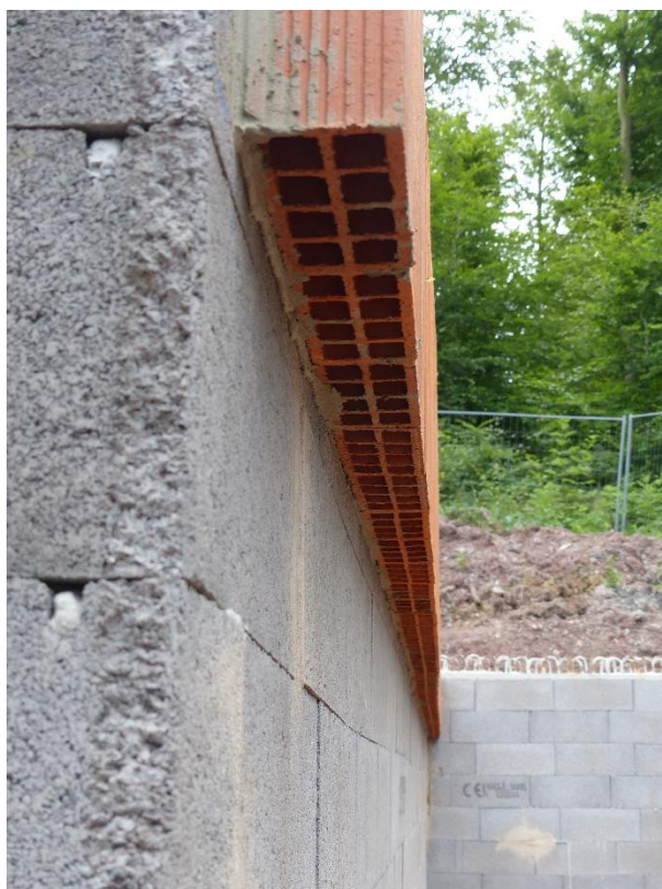
Figure 3 : exemple d'une rangée de briques plâtrières
