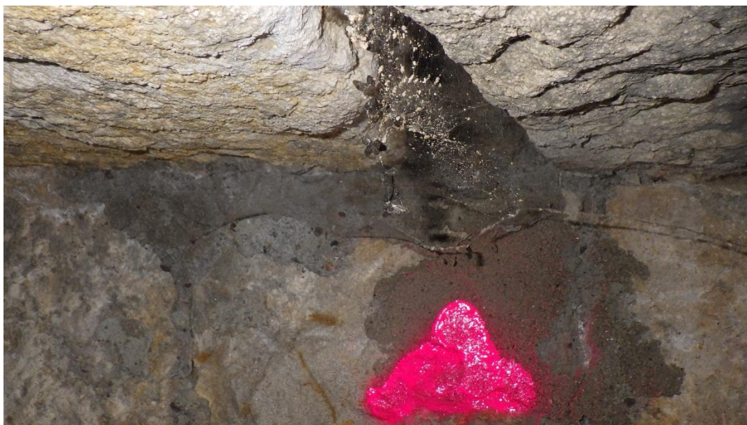
Figure 9 : marquage d'un disjointement utilisé
