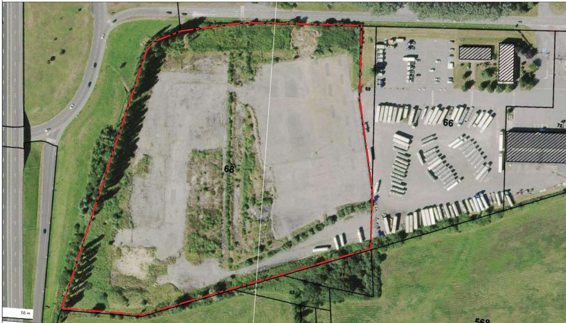
VUE AERIEENNE DU SITE ACTUEL
