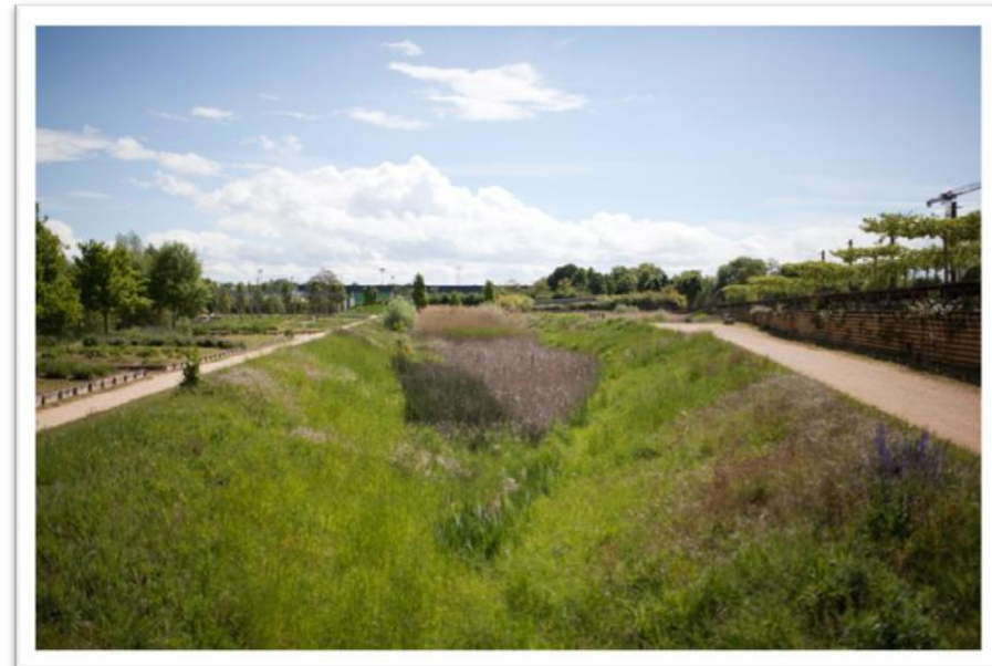
Gestion alternative des eaux pluviales sur une ancienne friche industrielle Source : Agence de l'Eau Rhin-Meuse
