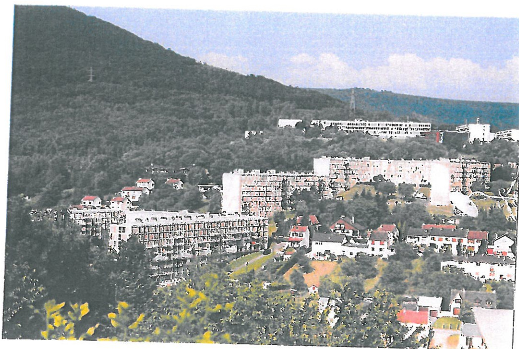
Vue du quartier d'ORZY : les barres des logements sociaux prévues en démolition Photo 1 er dossier de candidature ANRU 2009
