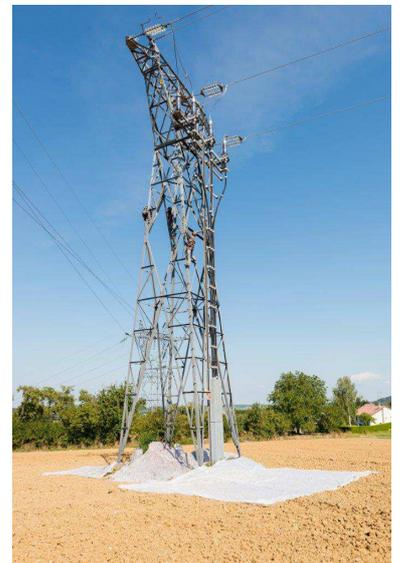
*Photos de travaux de mise en peinture de supports*
