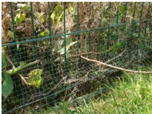
Photographie 10 et suivante : exemple d'une clôture à maille fine éventrée lors des travaux d'entretien (site d'étude, 2014) et d'une clôture à maille fine posée (site d'étude, 2017).
