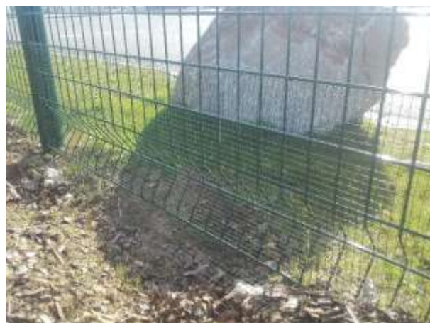
Photographie 10 et suivante : exemple d'une clôture à maille fine éventrée lors des travaux d'entretien (site d'étude, 2014) et d'une clôture à maille fine posée (site d'étude, 2017).
