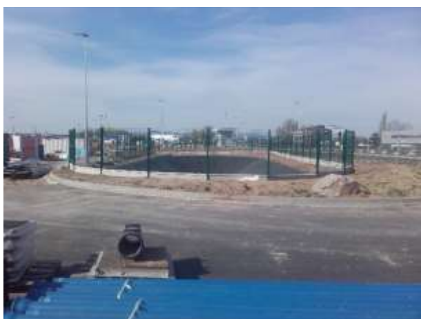
Photographie 11 : exemple d'un bassin correctement clos par une margelle béton (Lidl Entzheim, phase I, 2017).
