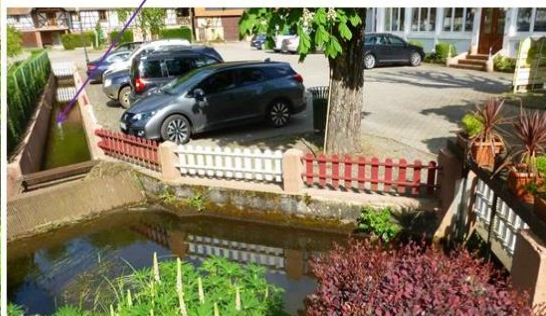
Canal (utilisation actuelle vivier + refroidissement frigos)
