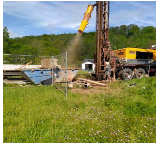
25 Atelier de forage à Varsberg, 2021
