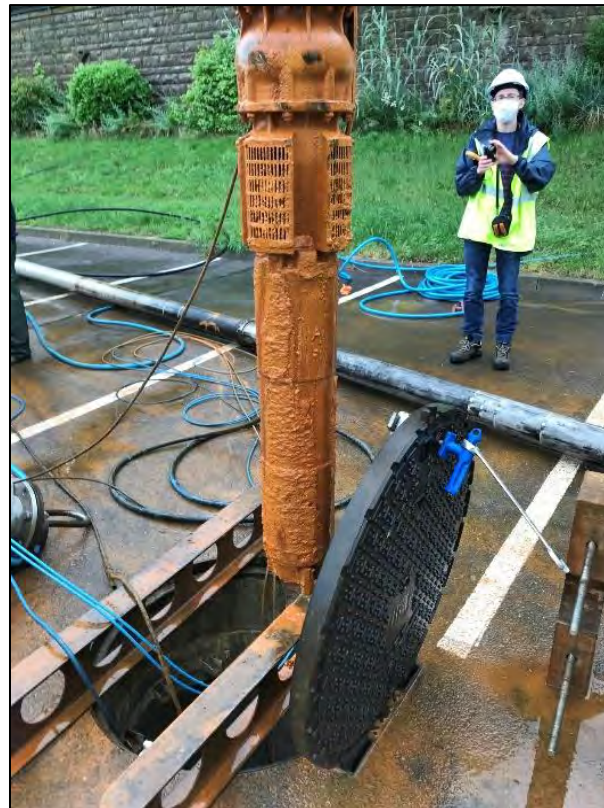
Pompe avec dépôts d'oxydes, 2021
