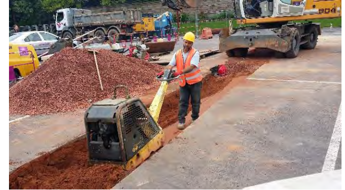
Pose de la conduite
