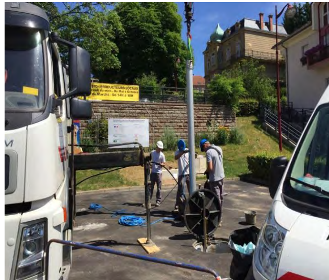
Fosse technique enterrée et mise en place pompe
