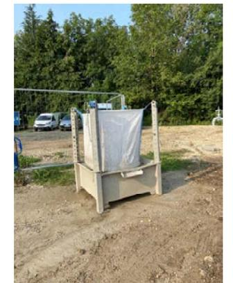
Système de filtration des eaux de nettoyage des toupies de livraison de béton :
