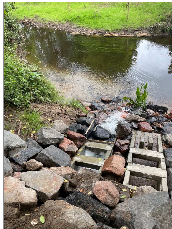
Rejet du forage (à gauche) et de la CCW (à droite)
