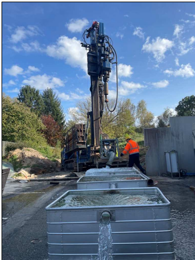
Réalisation du forage
