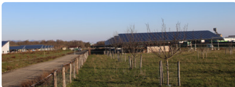
Exemple de local technique intégré directement sous l'ombrière photovoltaïque. ©Territoires & Paysages
