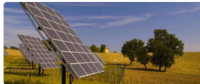
Exemple de tracker solaire
