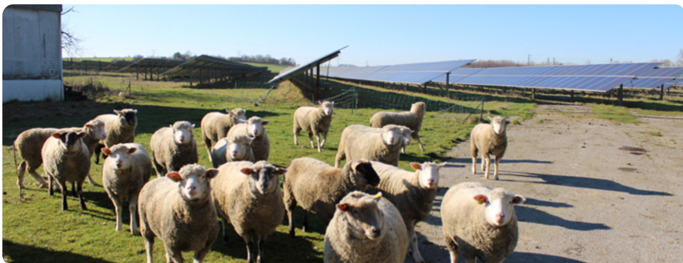
Parc photovoltaïque de Béthéniville (51) en lisière villageoise sur l'ancien site d'une distillerie camouflée par sa situation en fond de vallon et la ripisylve du cours d'eau. - © Territoires & Paysages
