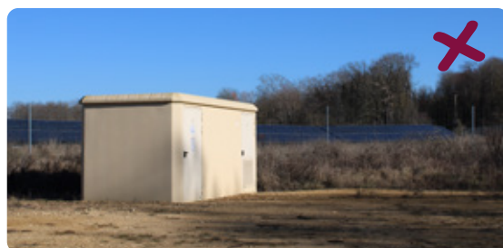
Exemples de locaux techniques à proscrire, l'utilisation du blanc ou du vert ne permet pas une intégration paysagère optimale. ©Territoires & Paysages
