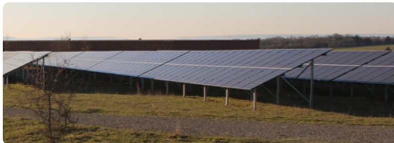
Exemple d'une implantation soignée. Les ancrages rattrapent le niveau naturel du sol et la végétation herbacée s'y est installée. © Territoires & Paysages
