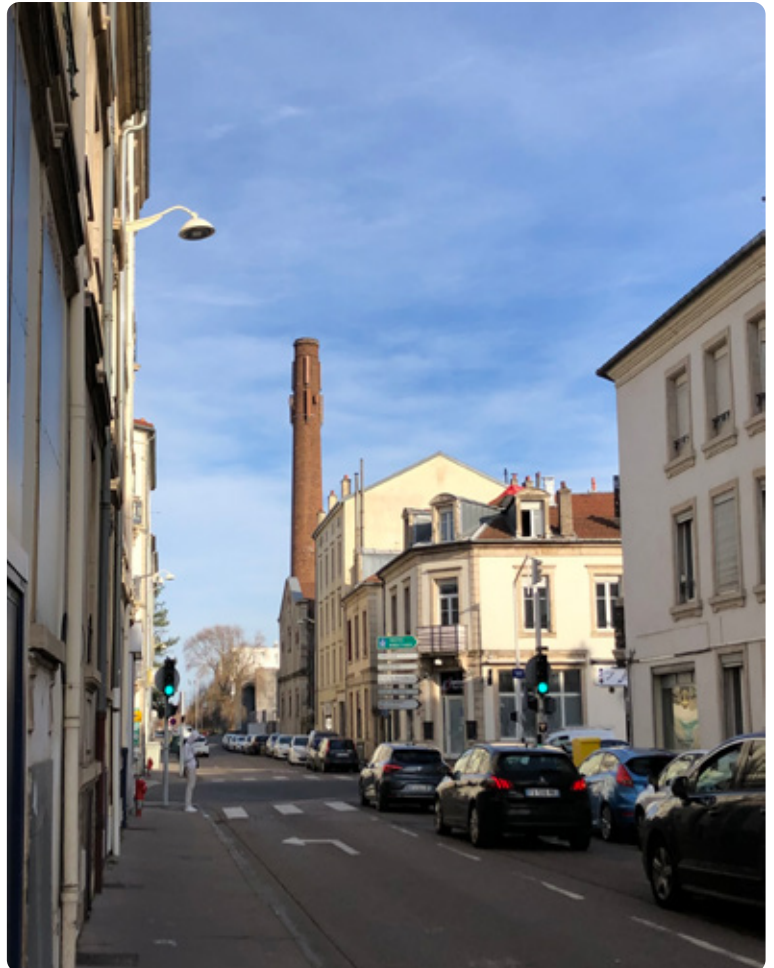
Antenne-relais intégrée à la cheminée d'un bâtiment situé dans un périmètre de Monument Historique à Nancy (54)
