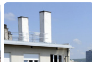
Ces antennes-relais sont implantées en mimétisme avec le bâtiment. En imitant des cheminées, elles proposent une intégration parfaite à l'immeuble possédant déjà des éléments en surélévation sur la toiture-terrasse. © L'Est Républicain
