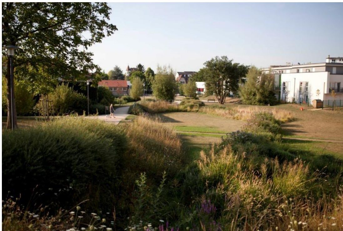
Illustration 4 - Scy-Chazelles (57) - Bassin paysager de type plaine inondable - Guide gestion intégrée des eaux pluviales - Agence de l'eau Rhin-Meuse
