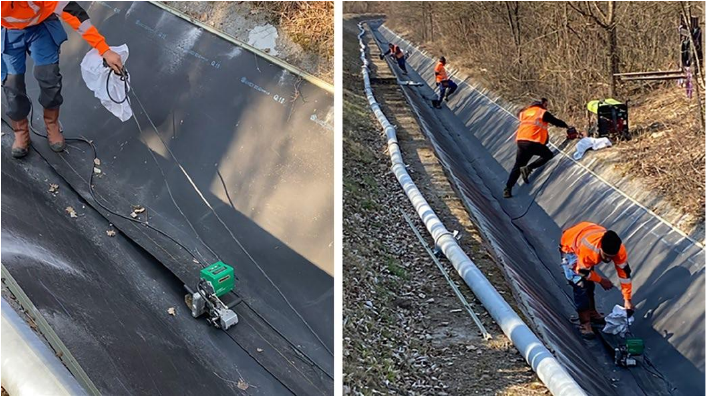
Figure 4 - Réalisation des soudures longitudinales, transversales et fixation de l'ancrage longitudinal © BRGM, 2022
