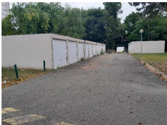
Garage et allée bétonnée
