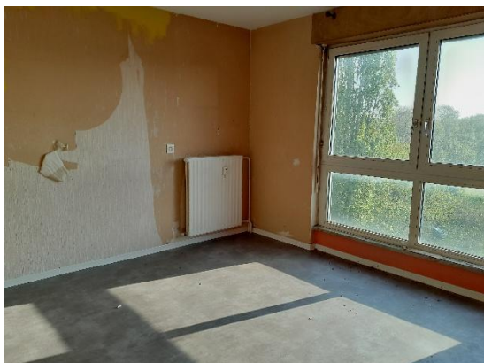
Intérieur du bâtiment
