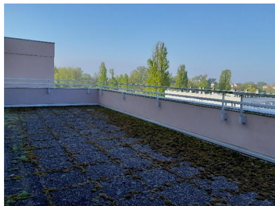
Terrasse au dernier étage
