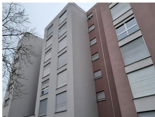
Façade ouest du bâtiment
