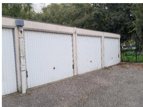
Garages et voies d'accès (
