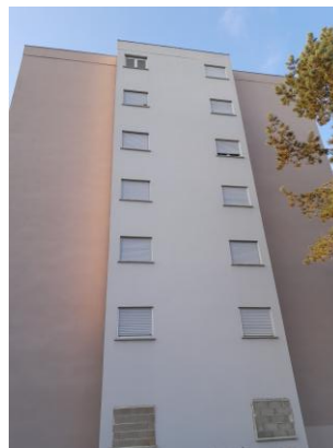
Bâtiment (milieux anthropiques)
