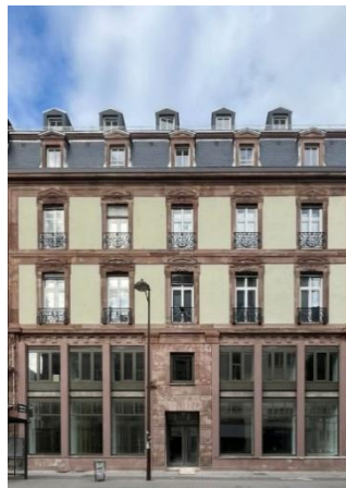
Transformation de l'ancien siège de la Chambre Régionale des Comptes en résidence Jeunes, inaugurée le 03 juin 2025 à Strasbourg et portée par DOMIAL et la FTI
