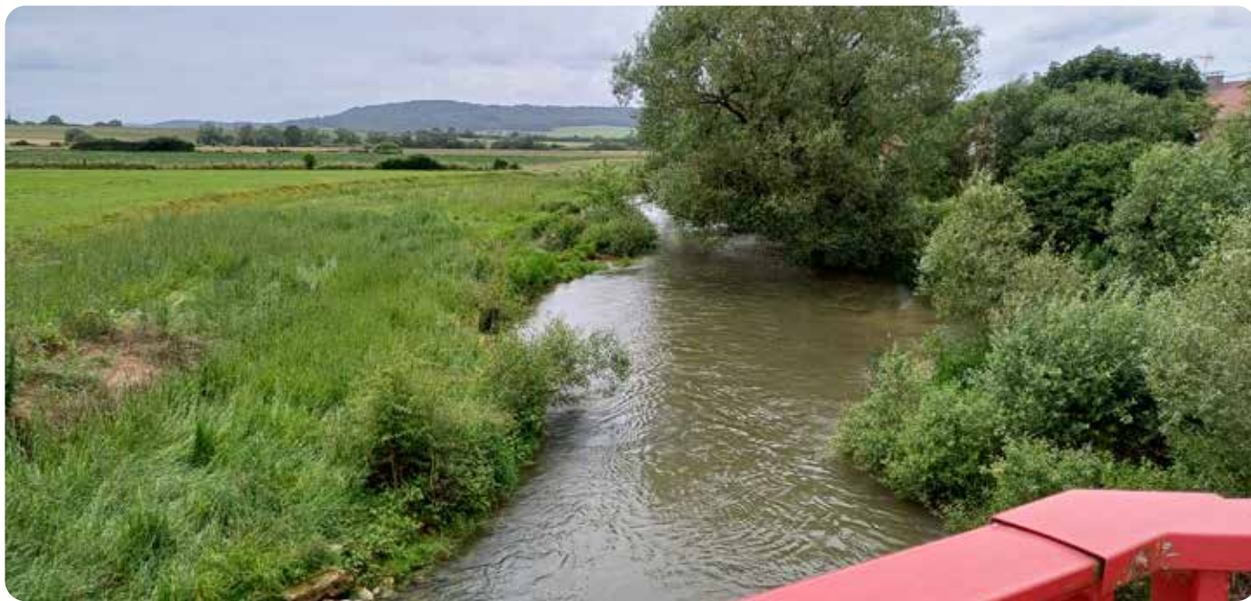
Vue depuis le pont de la RD3a sur les travaux de décaissement (juin 2024) (crédits © DREAL GE)
