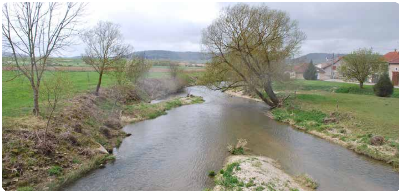
Vue depuis le pont de la RD3a avant les travaux de décaissement (crédits © EPAMA)
