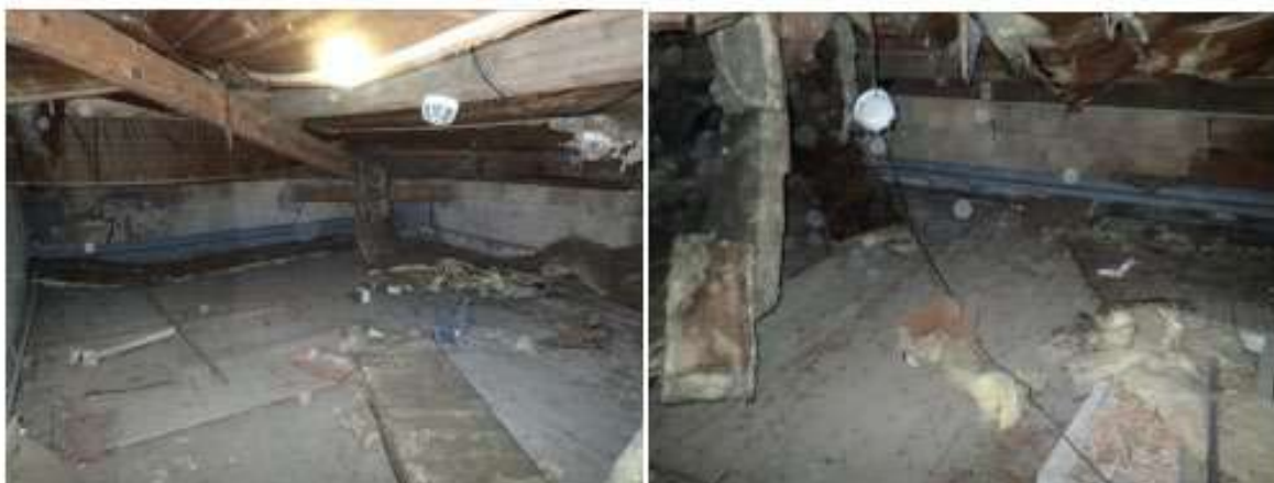
Les greniers sont en mauvais état avec une isolation sous toiture qui s'effondre
