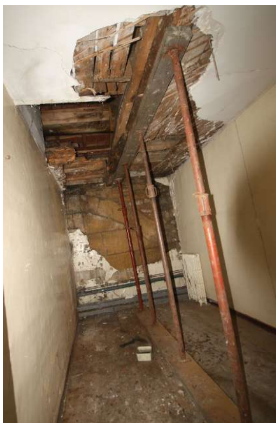
Figure 15 : état sanitaire de la charpente
