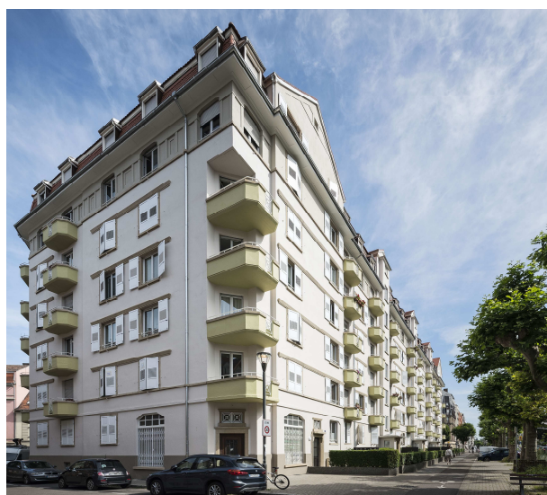
Figure 6 : vue après travaux ©D.PARENT, Habitation Moderne
