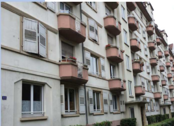
Figure 2 : façade sur rue avant travaux.
