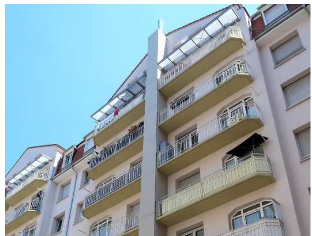
Figure 5 : façade sur cour après travaux Photo : Urbanetic architectes et urbanistes
