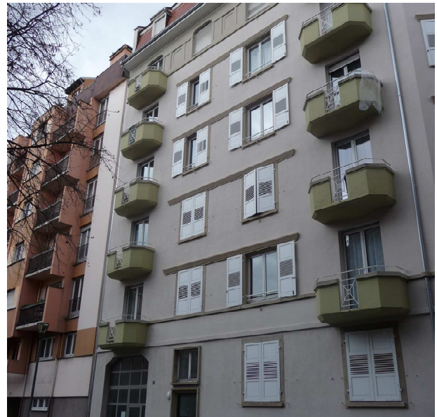
Figure 4 : façade sur rue après travaux (photo Cerema)
