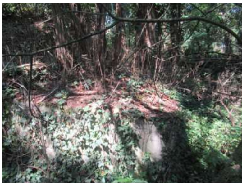
Fondations de bâtiments disséminées dans le bosquet
