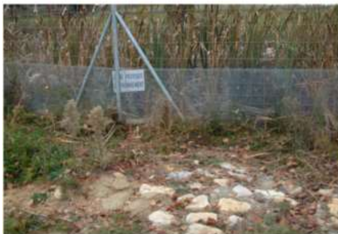
Clôture grande faune de type 3 associée à un grillage petite faune de type 6 (source : CEREMA)
