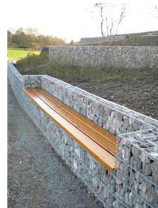
Figure 34 : Exemple de bancs en gabions
