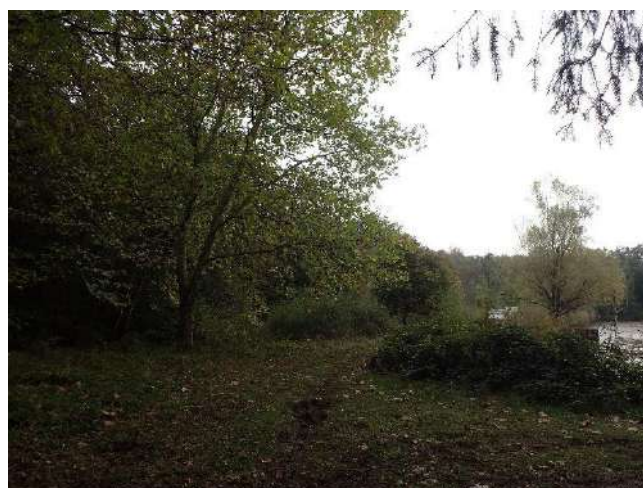
Photo 2 : début du barrage, rive gauche, arrivée par le chemin forestier
