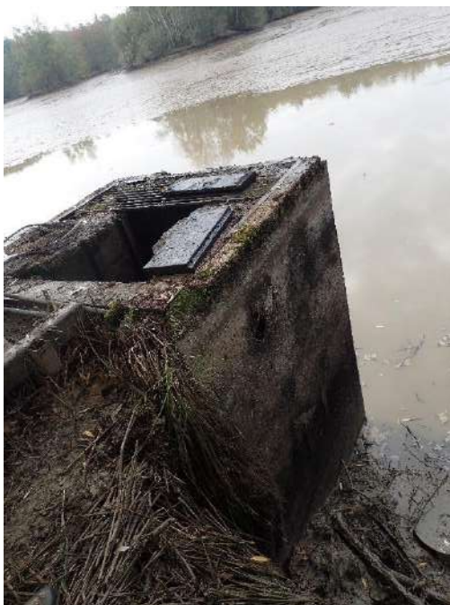
Photo 31 : moine vu depuis le haut du barrage
