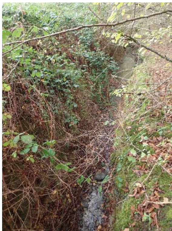
Photo 13 : canal d'évacuation en pied de barrage
