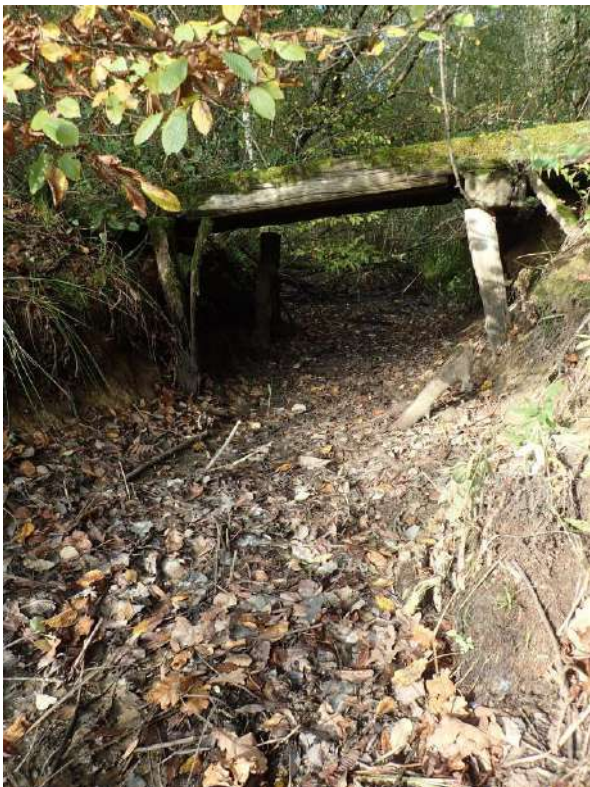
Photo 45 : petite passerelle au-dessus du fossé
