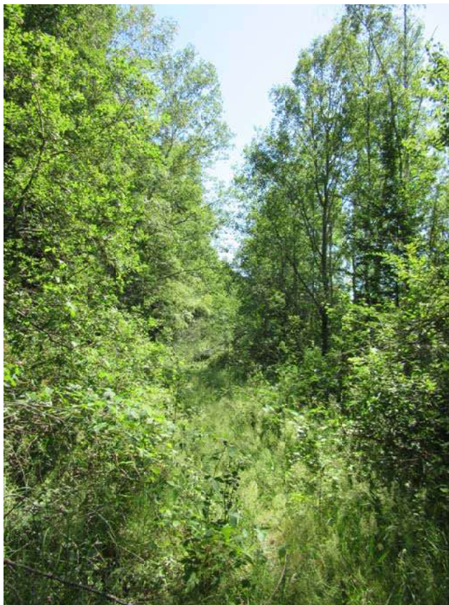
Sentier en arrière de la digue en juillet 2019
