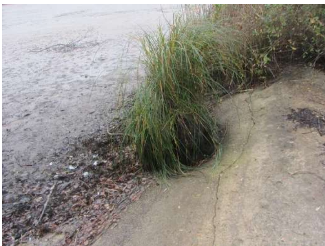
Photo 19 : pente amont de l'EVC
