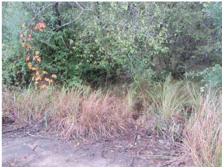
Photo 11 : vue sur le parement amont au niveau de l'EVC
