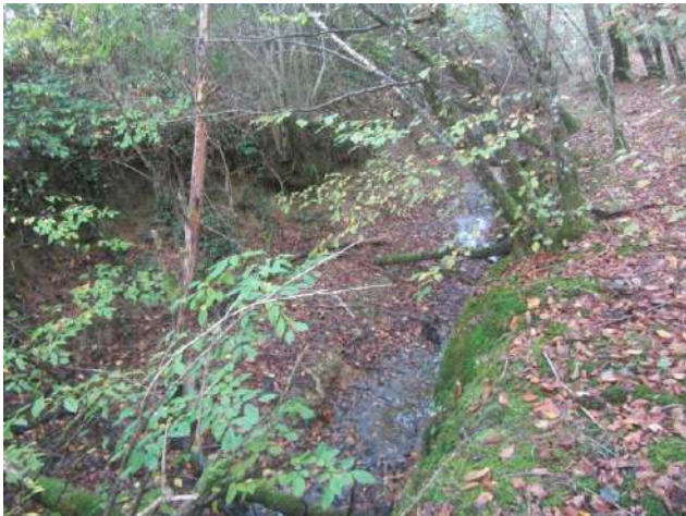
Photo 27 : canal d'évacuation encaissé au niveau du pied aval du barrage
