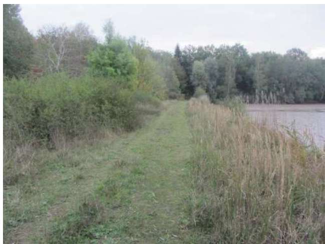
Photo 1 : vue générale du barrage
