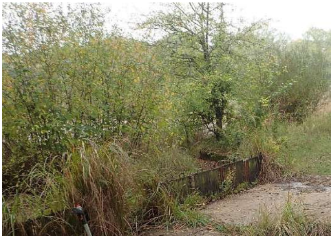
Photo 21 : muret et grilles
