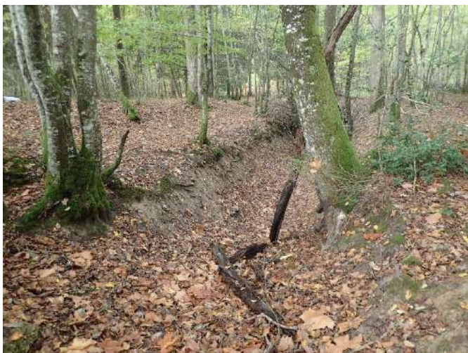
Photo 16 : pied aval du barrage, côté rive gauche
