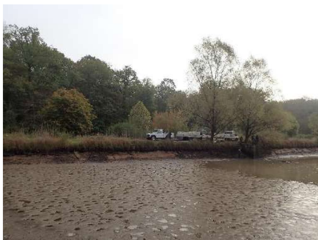
Photo 3 : vue générale sur le barrage
