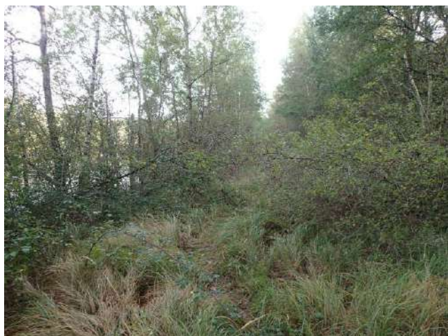
Photo 39 : digue rive droite
