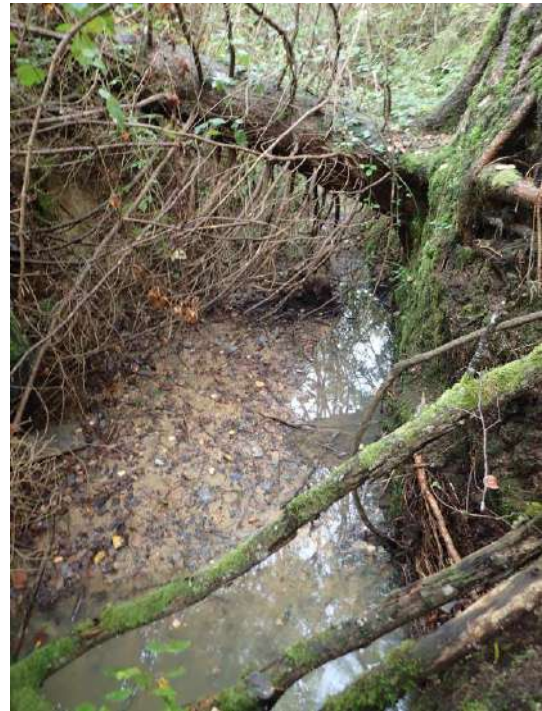
Photo 26 : canal d'évacuation encaissé (pied aval du barrage)
