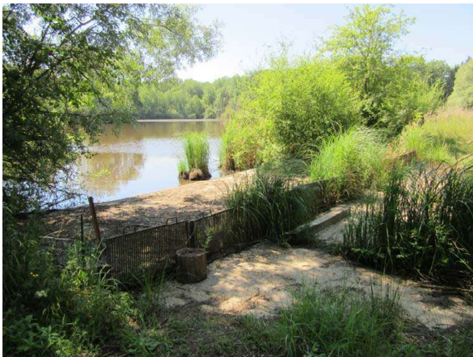
Déversoir de l'étang à sec le 4 juillet 2019.
