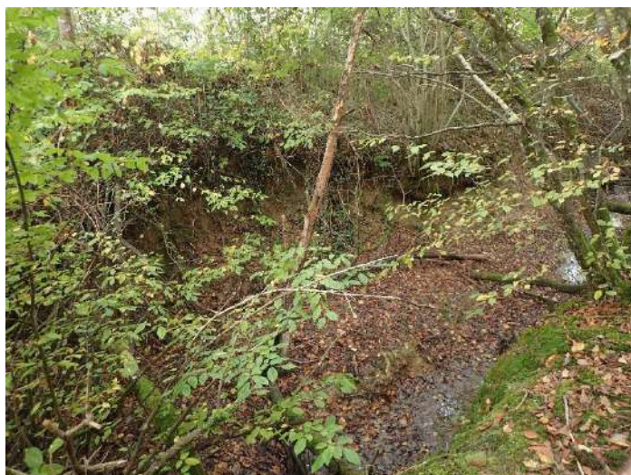
Photo 12 : canal d'évacuation en pied de barrage, côté rive droite
