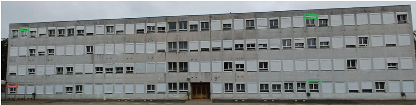
Figure 18 : Vue générale de la façade ouest de l’externat, © LADT, 2025
