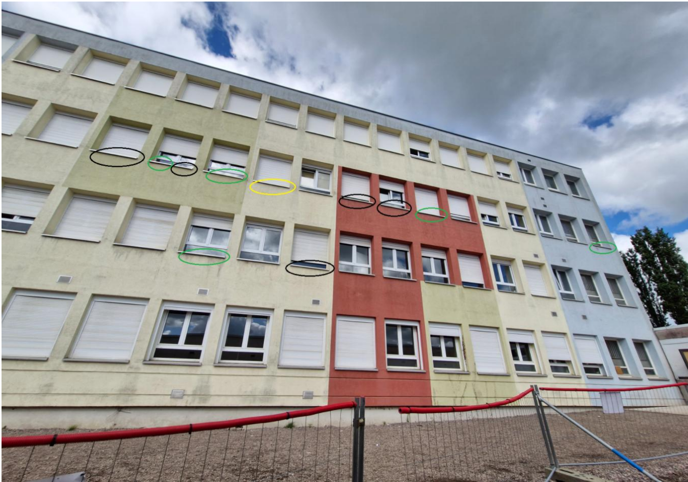
Figure 20 : Localisation des sites de nidification sur la moitié nord de la façade ouest de l'externat, © EODD, 2026
