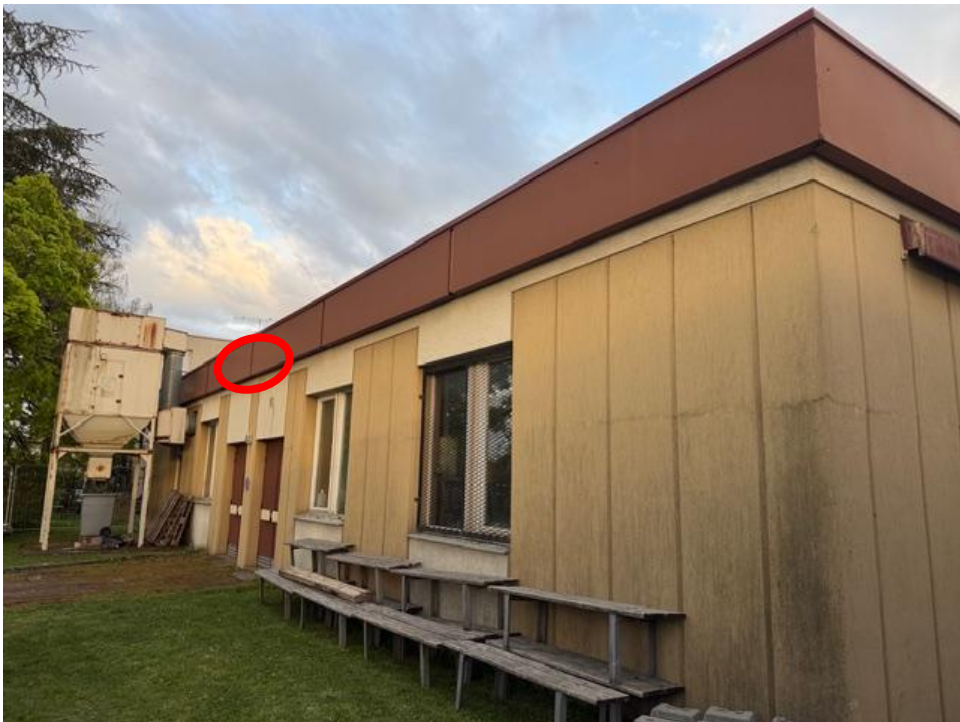
Figure 25 : Vue de la façade nord de l’atelier complémentaire, avec mise en évidence de la localisation de sortir de gîte de Noctule de Leisler (ellipsoïde rouge), © CPEPESC-Lorraine 2026
