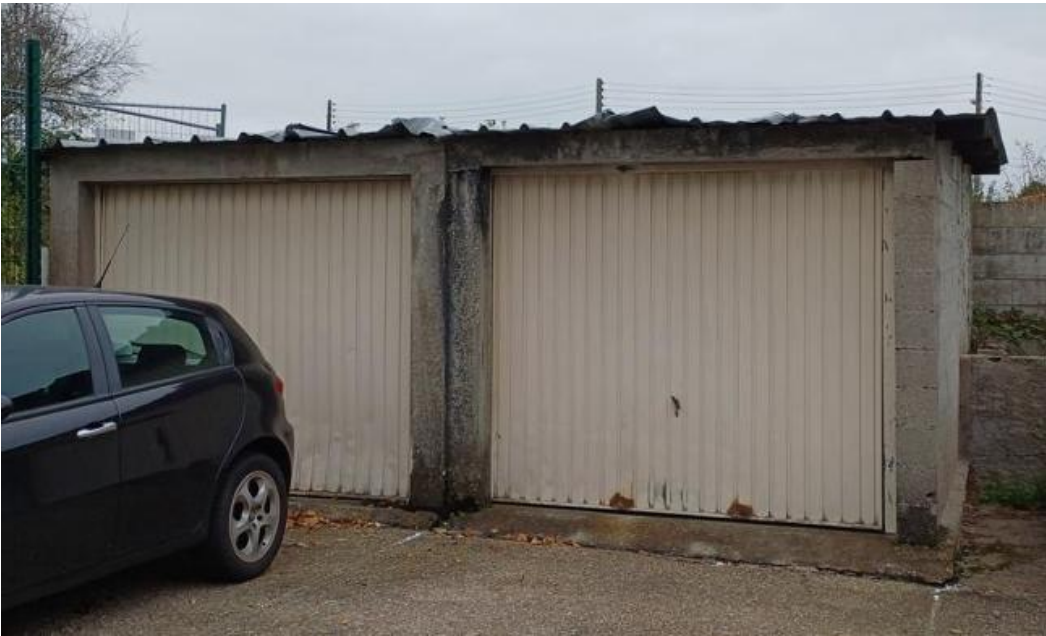
Figure 14 : Façade sud des garages, © LADT, 2025
