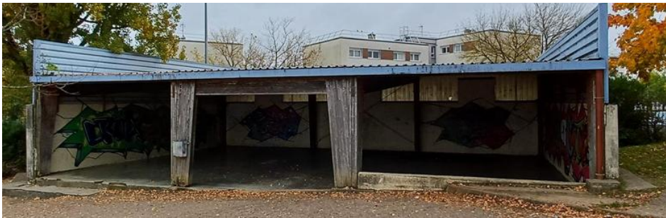
Figure 22 : Vue générale du préau, © LADT, 2025
