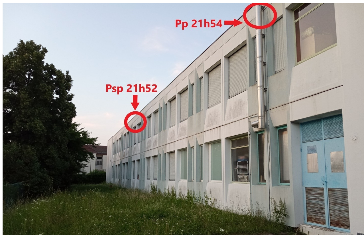
Figure 11 : Localisation des espèces sorties du bâtiment 1, façade ouest, sortie de juin 2025
